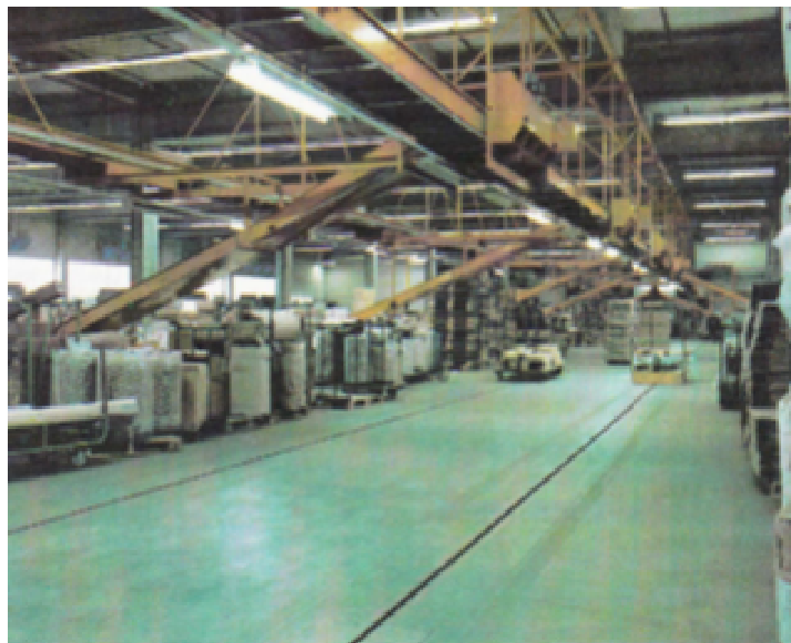
COLFLOOR ST-W in einem Stahllager
